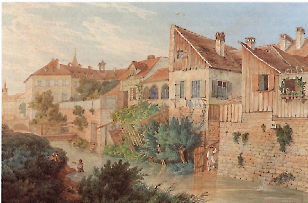
Die Modellstadt von der Rückseite um das Jahr 1840. Am Landgraben entlang der heutigen Steinstraße stehen die Häuschen des „Dörfle“. Im Hintergrund das Bürgerhospital am Lidellplatz
