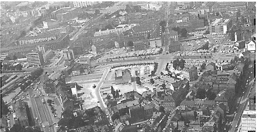
Das Sanierungsgebiet vor dem Wiederaufbau
