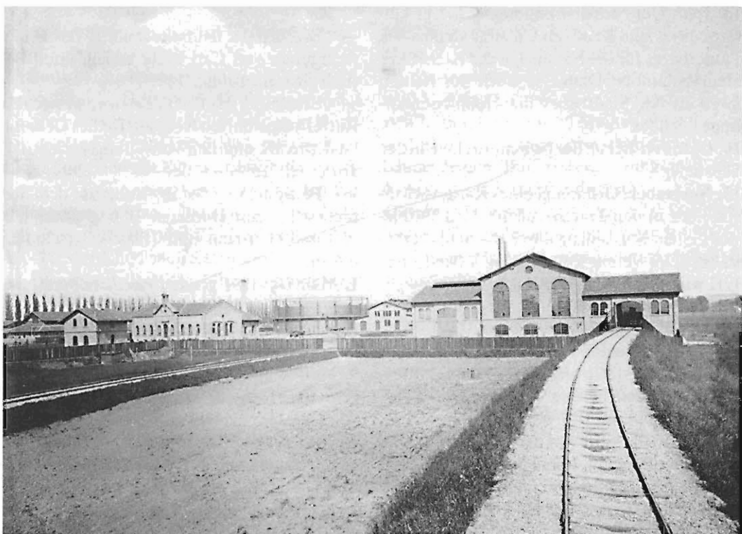
Das zweite Gaswerk im Osten der Stadt wird 1886 in Betrieb genommen
