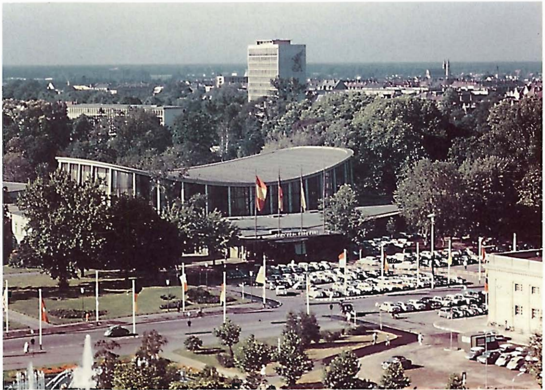
Die Schwarzwaldhalle am neugestalteten Festplatz, als Ausstellungs-, Sport- und Kongreßhalle von Erich Schelling geplant, wurde 1953 fertiggestellt
