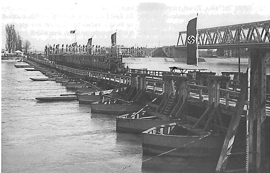
Die neue, am 17. Januar 1938 freigegebene Rheinbrücke, im Vordergrund die alte Schiffsbrücke
