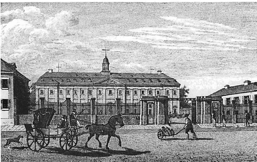
Das nach Plänen von Jeremias Müller 1780 errichtete Zeughaus an der Langen Straße nahe dem Durlacher Tor. Es wurde während der Revolution am 13. Mai 1849 vergeblich belagert
