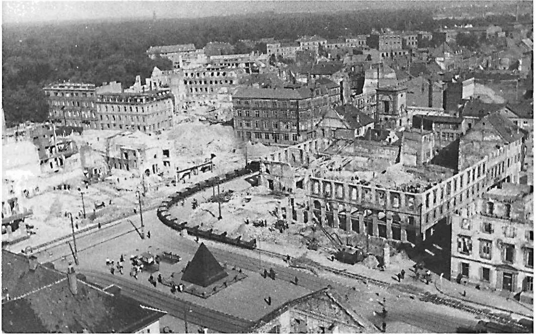
Blick auf das zerstörte Zentrum der Stadt am Marktplatz. Schon im September 1945 begann die „Enttrümmerung“, für die bald auch das „Schuttbahnle“ geschaffen wurde
