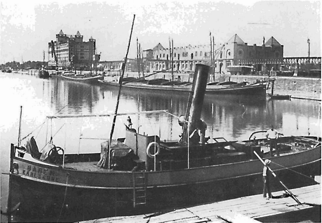
Städtischer Rheinhafen, Mittelbecken mit Werfthalle und Silospeicher um 1905
